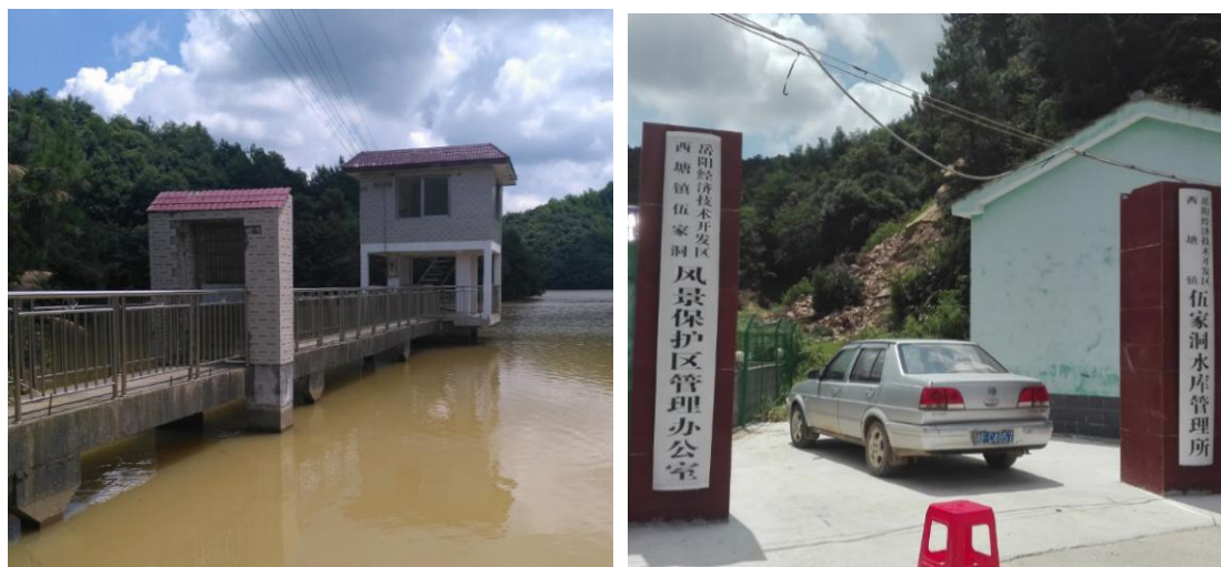
图 12水库取水泵房及管理所
